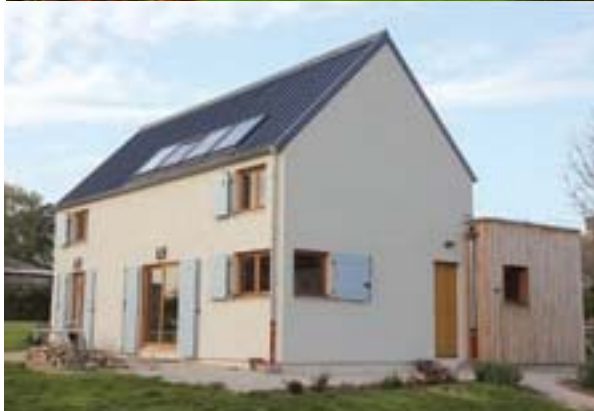
MAISON INDIVIDUELLE À BASSE CONSOMMATION ÉNERGIE MARIGNY-LES-REULLÉE (CÔTE-D'OR) ARCHITECTE : TOPOIEN STUDIO - DIJON TRAVAUX TERMINÉS
