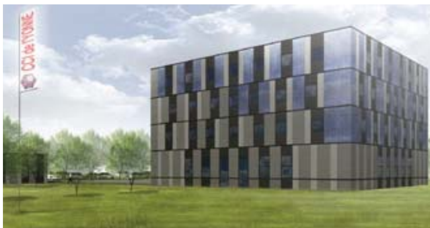
PÉPINIÈRE D'ENTREPRISE - SENS (YONNE) MAÎTRE D'OUVRAGE : CCI (CHAMBRE DE COMMERCE ET D'INDUSTRIE) - SENS ARCHITECTE : AGENCE PACE ARCHITECTE - REIMS BÂTIMENT À TRÈS BASSE CONSOMMATION D'ÉNERGIE FIN DES TRAVAUX : 3 e TRIMESTRE 2009
